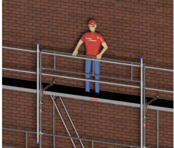
Beim Aufstieg auf die jeweils oberste Gerüstlage und bei der anschließenden Montage der Vertikalrahmen und Geländer kann Absturzgefahr bestehen.
